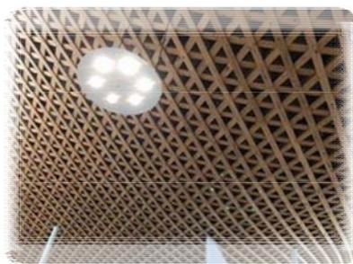
写真は、天井に使われている木製(ひのき)の格子構造で同時に屋根材としても使用されています。
