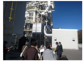
ボイラーの外観
