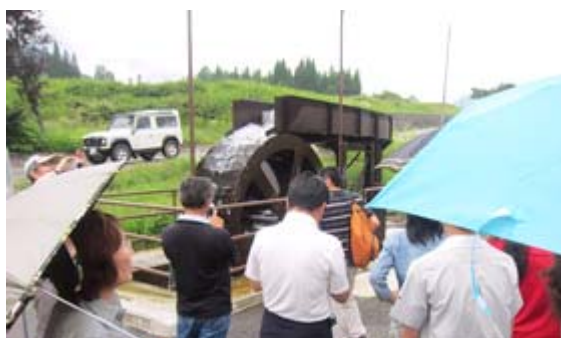
上掛け水車発電システム（定着型：バイパス方式）
