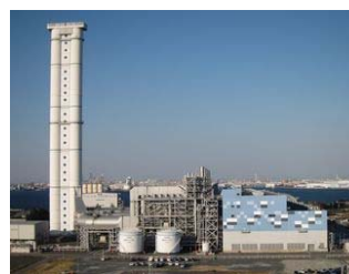
▲コンパクトな8号系列の建屋
