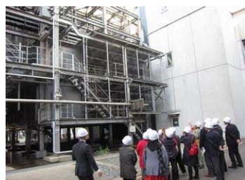
▲廃熱回収ボイラー、吸気室もあり、霧吹きすると空気をより吸い込むという
