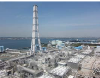
▲煙突の周りには、環境保全設備。
