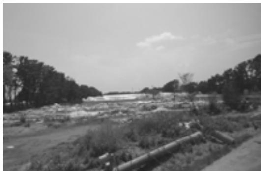
被災したビニールハウス
